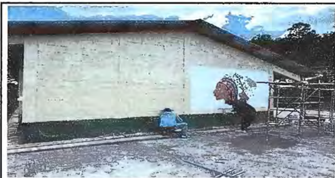
Modulo 2: Pintura en muros interior y exterior
