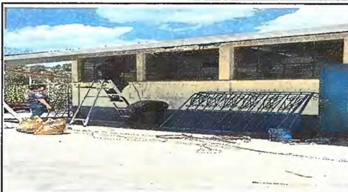
Foto 2. Modulo 1: Suministro e instalación de balcon de hierro en ventana
