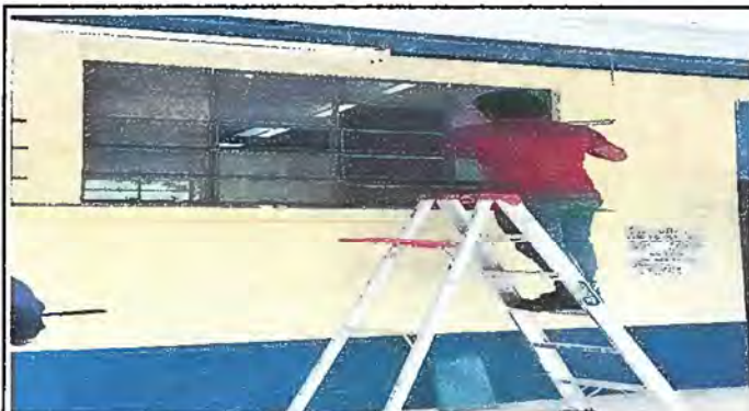
Foto 3. Modulo1: Sustitución de vidrios
