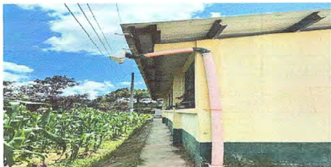
Foto 1. Modulo1: Sustitución de canales de PVC
