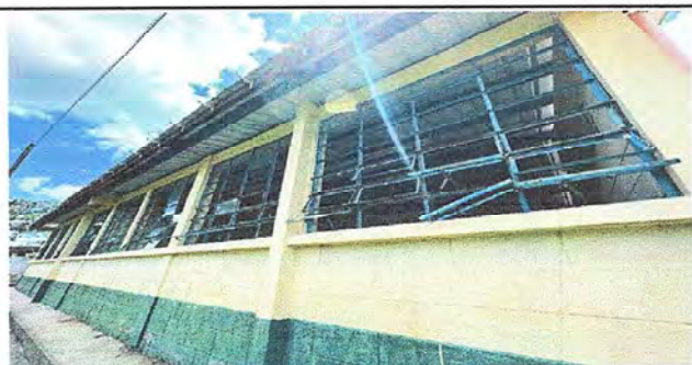
Foto 3. Modulo1: Sustitución de vidrios
