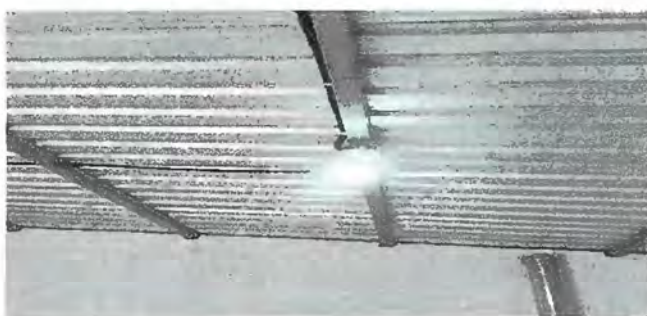
FOTO 1 MODULO 1 SUSTITUCIÓN DE LAMINA
