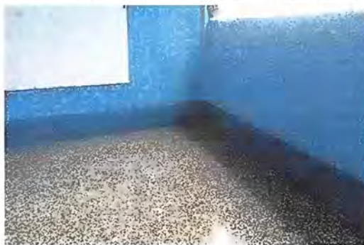
FOTO 8 MODULO 2 PINTURA DE MUROS
