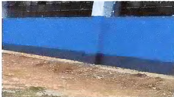
FOTO 16 MODULO 3 SUSTITUCIÓN DE TUBERÍA PVC AGUAS PLUVIALES
