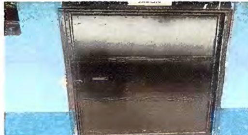
FOTO 12 MODULO 2 SUSTITUCIÓN DE PUERTA
