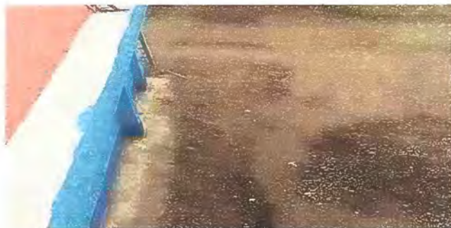
FOTO 15 MODULO 3 SUSTITUCIÓN DE TUBERÍA PVC Y ACCESORIOS
