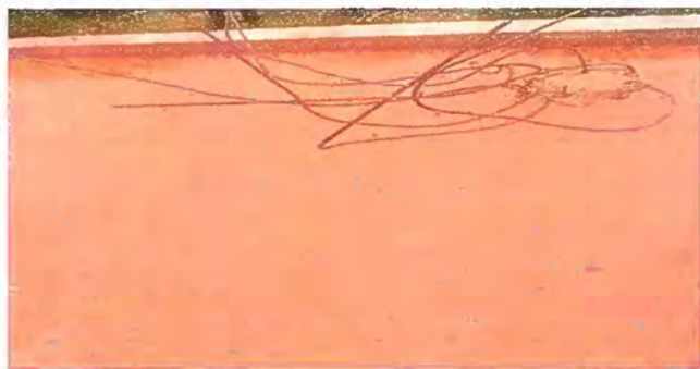
FOTO 13 MODULO 3 IMPERMEABILIZACIÓN DE LOSA
