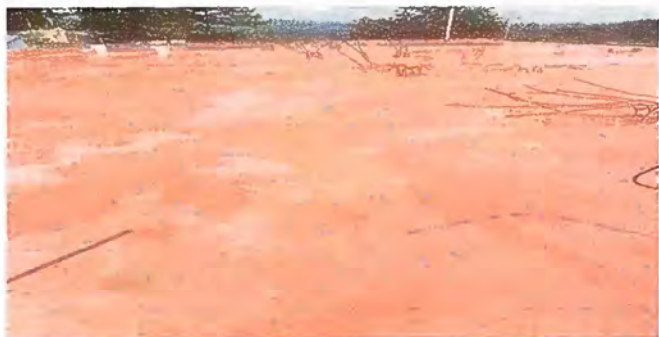
FOTO 13 MODULO 3 IMPERMEABILIZACIÓN DE LOSA
