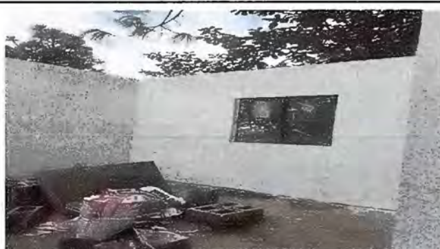
FOTO 3 MODULO 1 CERNIDO EN MURO REPELLO Y
