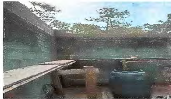
FOTO 2 MODULO 1 SUTITUCIÓN DE ESTRUCTURA DE SOPORTE COSTANERAS
