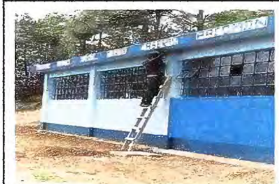
FOTO 8 MODULO 2 PINTURA DE MUROS
