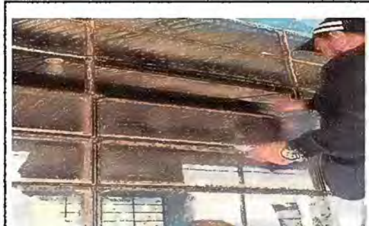
FOTO 10 MODULO 2 SUSTITUCIÓN DE VIDRIOS
