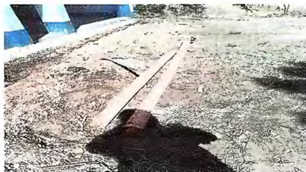
FOTO 16 MODULO 3 SUSTITUCIÓN DE TUBERÍA PVC AGUAS PLUVIALES
