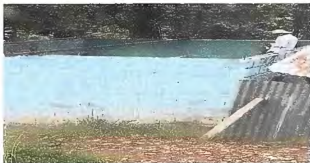
FOTO 1 MODULO 1 SUSTITUCIÓN DE LAMINA
