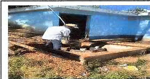
FOTO 9 MODULO 2 LIMPIEZA DE BIODIGESTOR
