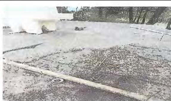
FOTO 6 PATIO SUSTITUCIÓN DE PILA
