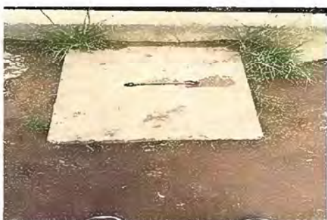
FOTO 9 MODULO 2 LIMPIEZA DE BIODIGESTOR
