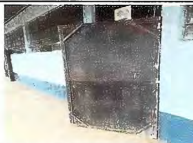
FOTO 12 MODULO 2 SUSTITUCIÓN DE PUERTA
