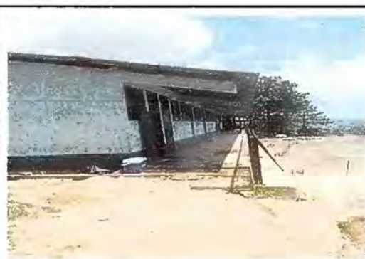
FOTO 8 MODULO 2 PINTURA DE MUROS
