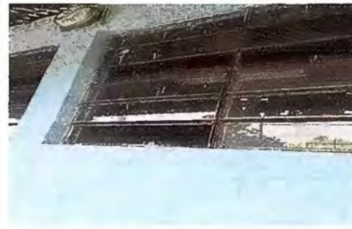
FOTO 10 MODULO 2 SUSTITUCIÓN DE VIDRIOS
