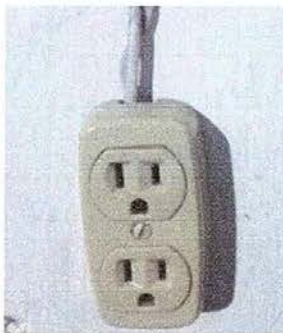
Foto 5: Sustitución de interruptores dobles
