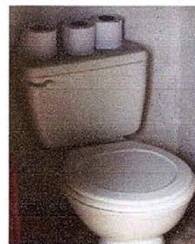
Foto 12: Sustrucción de accesorios de inodoros
