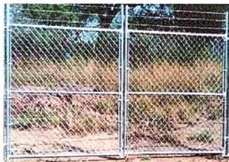
Foto 14: Mantenimiento de portón
