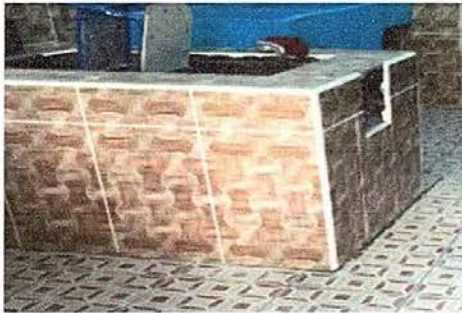
Foto 9: Sustrucción de chimenea de concreto
