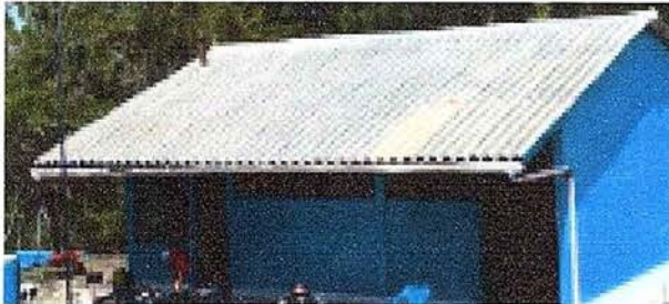
Foto 1: Sustitución de lámina a lámina troquelada aluzinc, calibre 26
