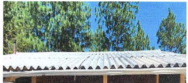
Foto 2: Limpieza de canales
