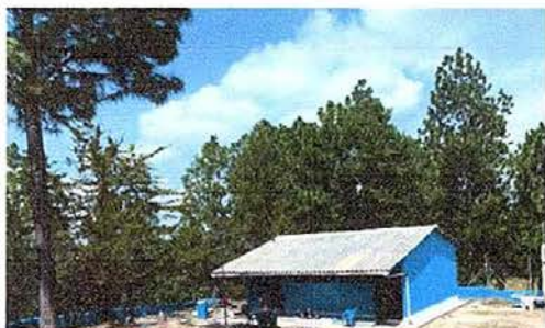
Foto 13: pintura en muros exteriores e interiores
