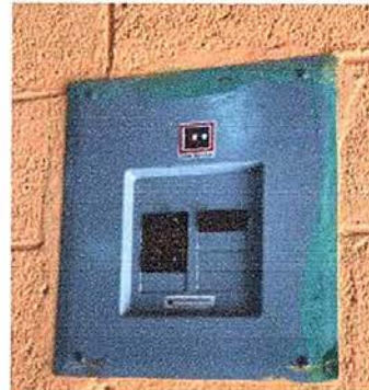
Foto 4: Sustitución de tablero de flipones
