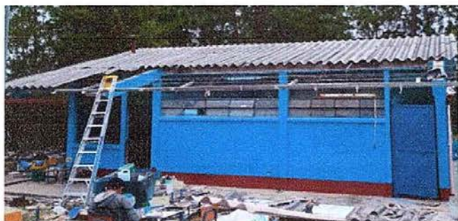
Foto 1: Sustrucción de lámina a lámina troquelada aluzinc, calibre 26
