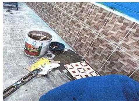
Foto 8: Suministro e instalación de azulejo en cocina
