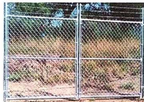
Foto 14: Mantenimiento de portón
