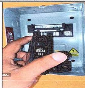
Foto 4: Sustrucción de tablero de flipones
