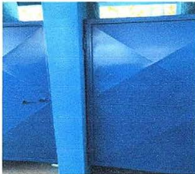
Foto 11: Mantenimiento en puertas en baños
