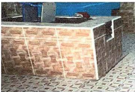
Foto 9: Sustitución de chimenea de concreto
