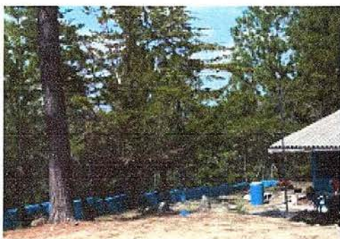
Foto 13: pintura en muros exteriores e interiores
