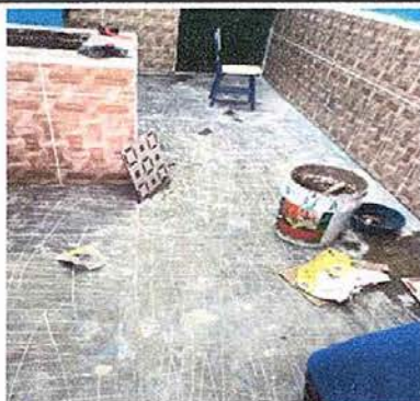
Foto 7: Sustitución de piso de torta de concreto por piso cerámico
