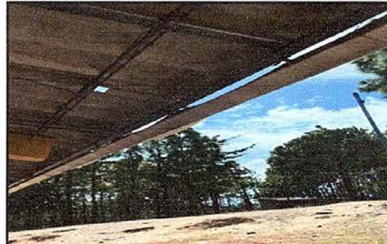
Foto 2: Limpieza de canales
