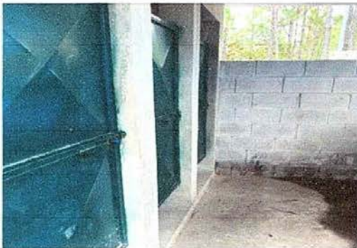
Foto 11: Mantenimiento en puertas en baños
