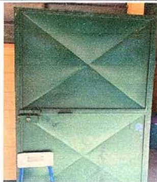
Foto 6: Mantenimiento a estructura de puerta
