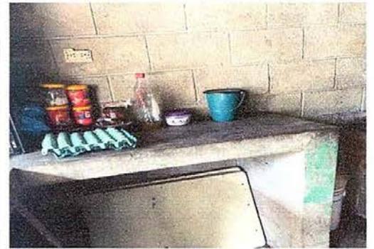
Foto 8: Suministro e instalación de azulejo en cocina
