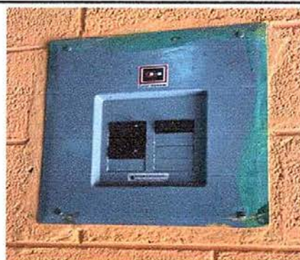
Foto 4: Sustrucción de tablero de flipones
