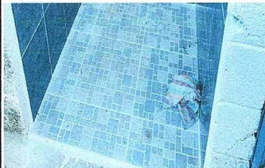
Foto 8: Sustitución de piso
