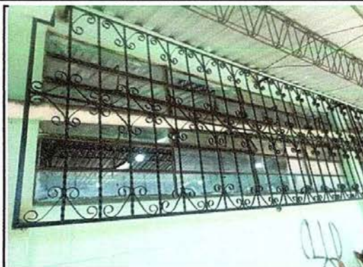
Foto 2: Mantenimiento de balcones de metal
