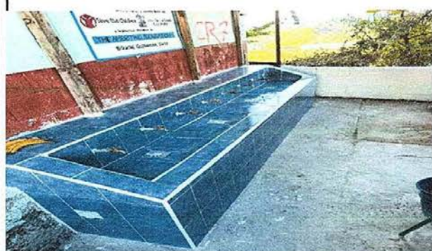
Foto 9: Sustitución de azulejo
