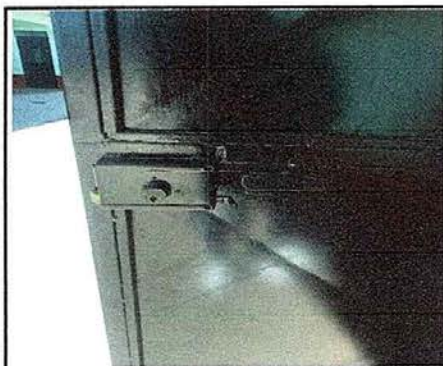
Foto 11: sustitución de chapa
