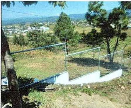
Foto 6: Reparacion de muro perimetral con tubo hg y malla galvanizada, soleras intermedias y columnas, pintura
