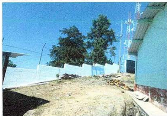
Foto 7: Pintura muro perimetral
