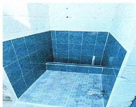
Foto 10: sustitución de azulejo e instalación de piso
