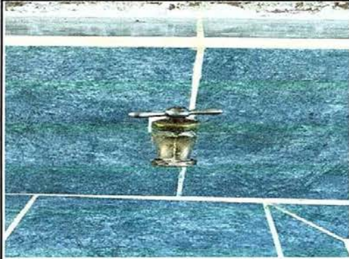
Foto 13: sustitucion de llave de chorro.
