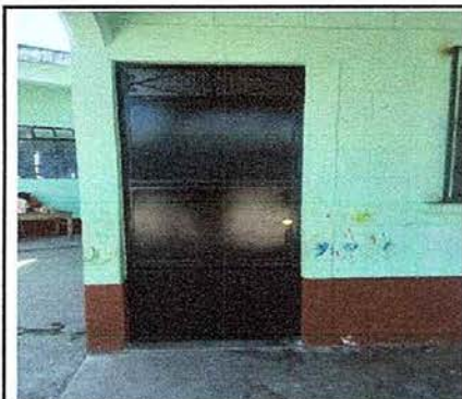
Foto 5: sustitución de puerta
