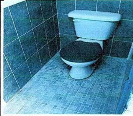
Foto 14: sustitucion de piso en baños
