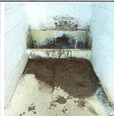
Foto 10: sustitucion de azulejo e instalacion de piso
