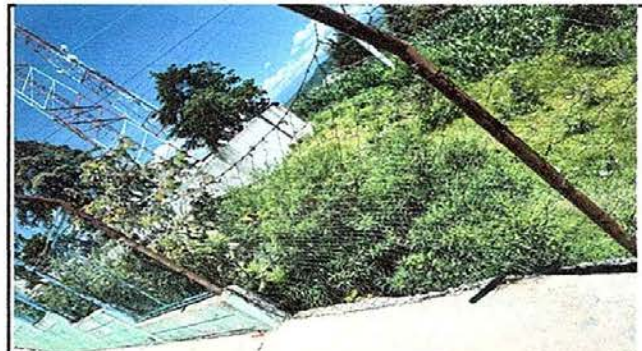
Foto 6: Reparación de muro perimetral con tubo hg y malla galvanizada, soleras intermedias y columnas, pintura
