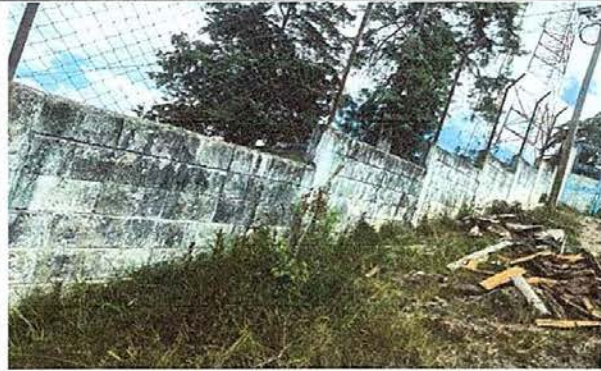
Foto 7: Pintura muro perimetral
