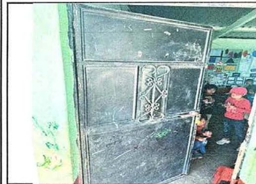
Foto 5: Sustitución de puerta de metal
