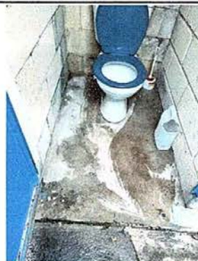
Foto 8: Sustitución de piso
