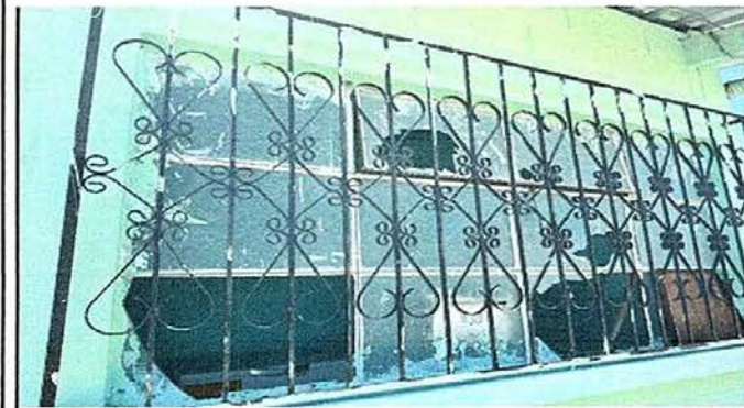
Foto 3: Sustitución de vidrios
