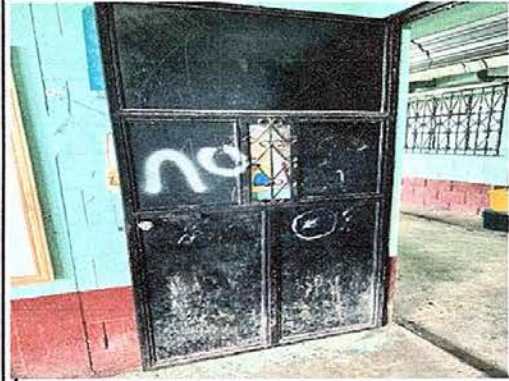
Foto 1: Mantenimiento de estructura de puerta (lijado, cambio de tubo, cepillado, sujeciones, aplicación de pintura)
