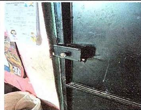
Foto 11: sustitución de chapa
