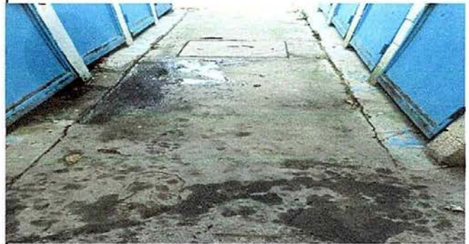
Foto 8: Sustitución de piso
