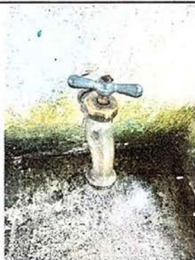
Foto 13: sustitución de llave de chorro.
