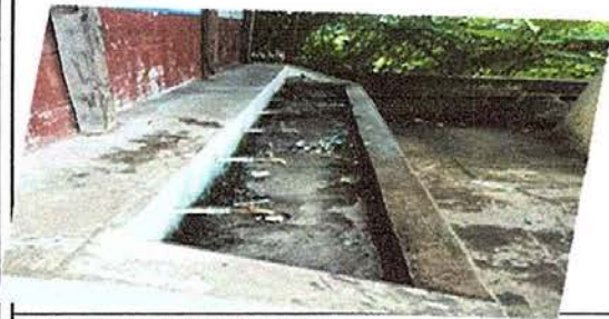
Foto 9: Sustitucion de azulejo
