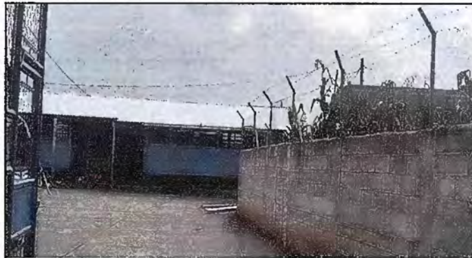
Foto 2: MODULO 1: Instalacion de Laminas por lamina Troquelada
