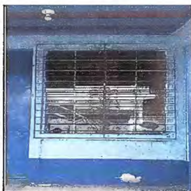
Foto 5: MODULO 1: Mantenimiento de Balcones de Metal
