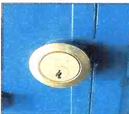
Foto 11: MODULO 2: Instalacion de Chapa
