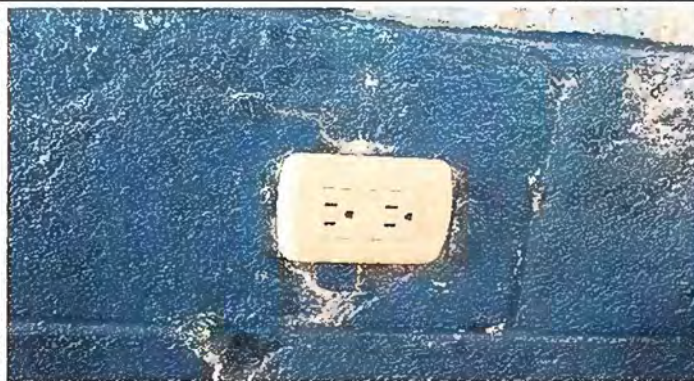
Foto 7: MODULO 2: Instalacion de Tomacorrientes
