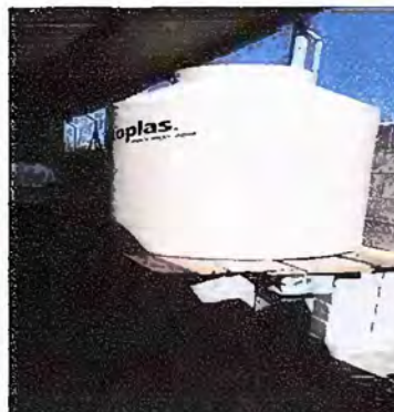
Foto 10: MODULO 3: Instalacion de Deposito Rotoplas
