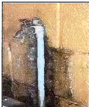
Foto 9: MODULO 2 Instalacion tuberia agua potable
