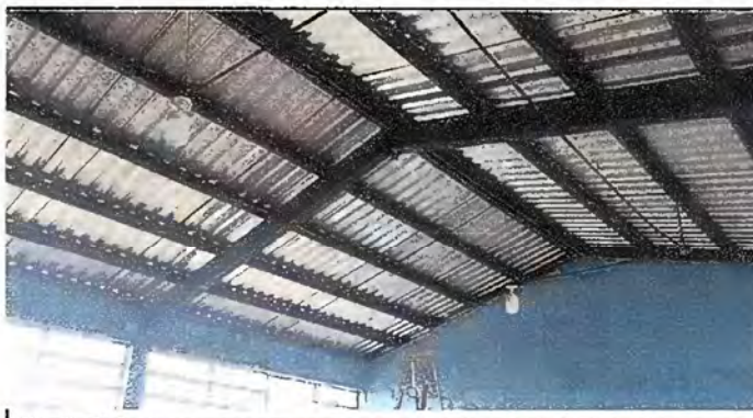
Foto 4: MODULO 1: Instalacion de plafoneras
