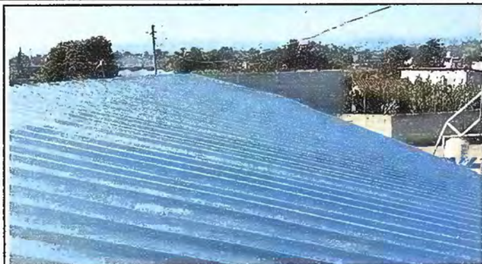
Foto 1: MODULO 1: Sustitucion de Capotes para Lamina Troquelada
