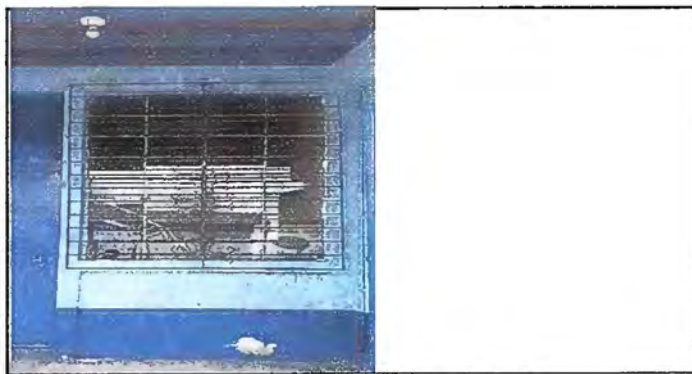
Foto 5: MODULO 1: Mantenimiento de Balcones de Metal
