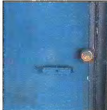
Foto 10: MODULO 2: Sustitucion de Chapa
