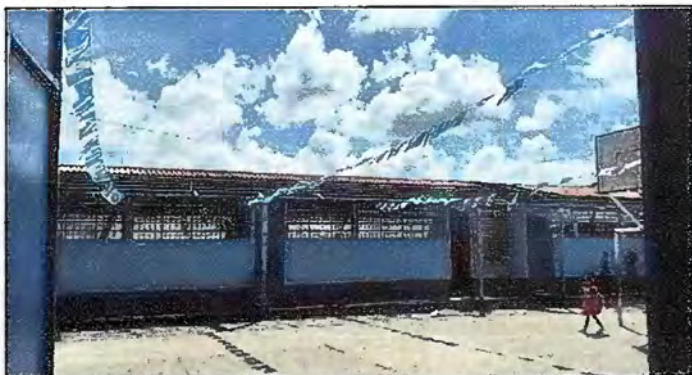
Foto 3: MODULO 1: Desinstalacion de Laminas
