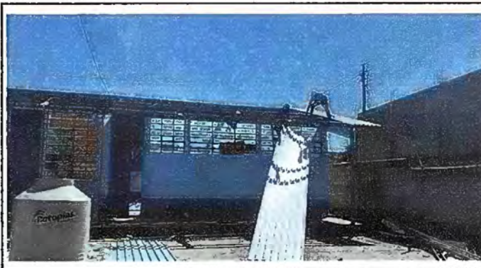
Foto 2: MODULO 1: Sustitucion de Laminas por lamina Troquelada
