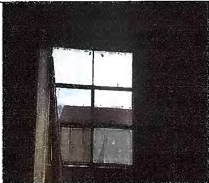
Foto 13: MODULO 4: Sustitucion de Vidrios
