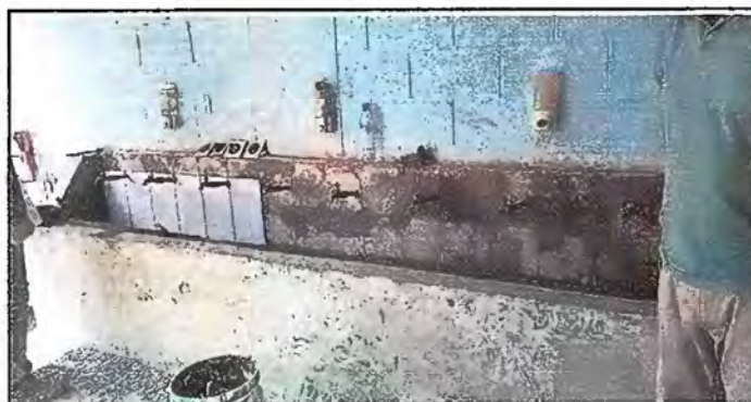
MODULO 17: Sustitución de Chorros , sustitución de Azulejo
