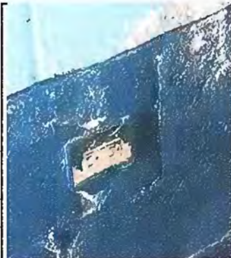
Foto 9: MODULO 2 Sustitucion de Tomacorrientes
