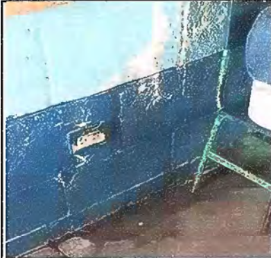
Foto 7: MODULO 1: Sustitucion de Tomacorrientes
