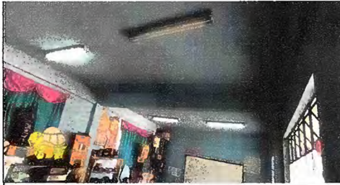
Foto 8: MODULO 2: Sustitucion de Focos Ahorradores
