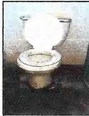
Foto 14: MODULO 5: Sustitucion de Sanitarios
