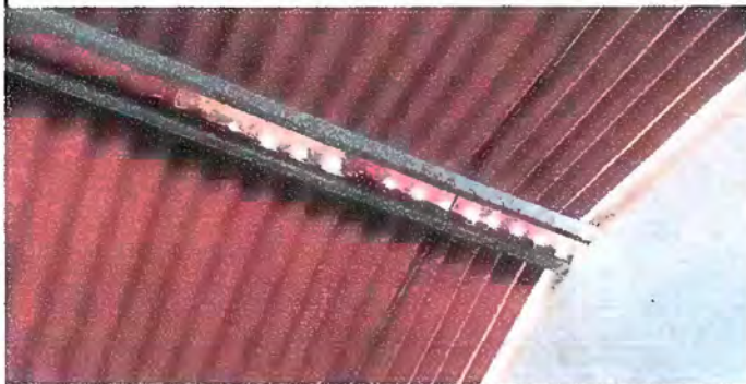
Foto 1: MODULO 1 : Sustrucion de Capotes para Lamina Troquelada
