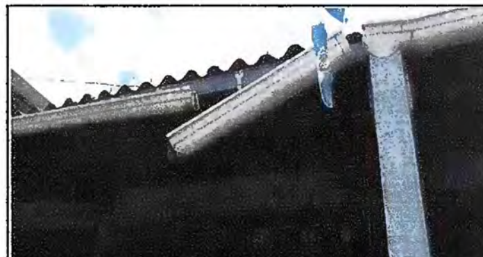
Foto 4: MODULO 1: Sustrucion de Canales de Pvc
