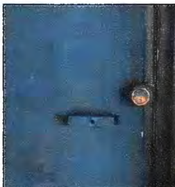
Foto 10: MODULO 2: Sustitucion de Chapa
