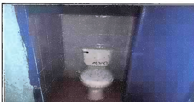
Foto 6: MODULO 1 INSTALACION DE INODORO
