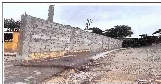
Foto 5: MODULO 1 REPARACION DE MURO PERIMETRAL DE BLOCK
