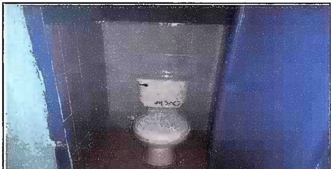
Foto 6: MODULO 1 INSTALACION DE INODORO
