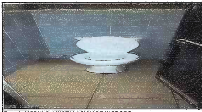
Foto 6: MODULO 1 INSTALACION DE INODORO
