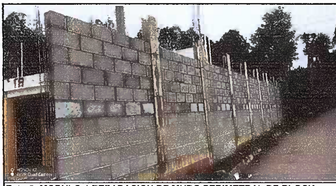
Foto 5: MODULO 1 REPARACION DE MURO PERIMETRAL DE BLOCK
