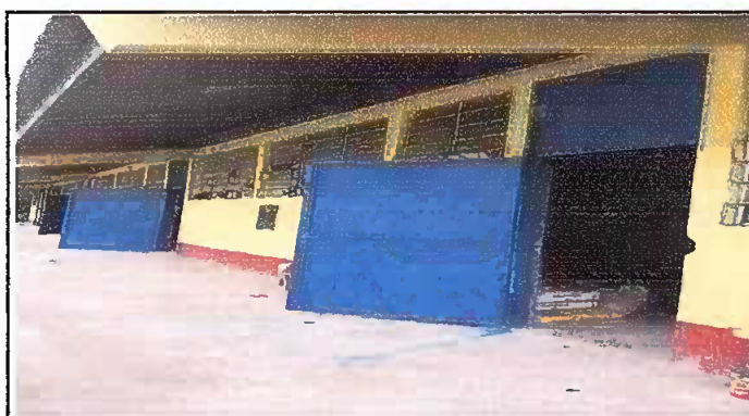
Foto 4: MODULO 1 SUSTITUCION DE CHAPA
