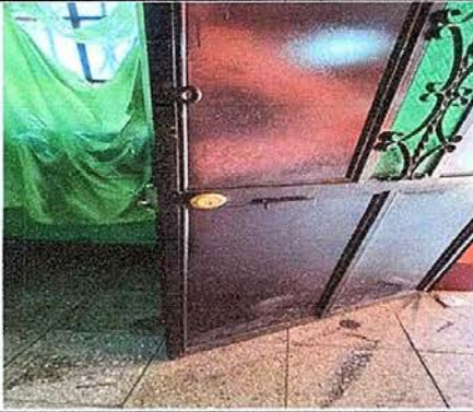
Foto 7: MODULO 2 sustitucion de chapa
