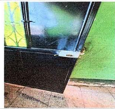
Foto 8: MODULO 2 sustitucion de chapa
