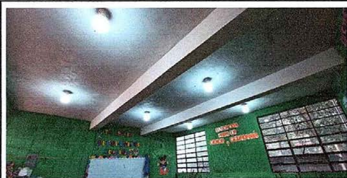
Foto 5: MODULO 1 se muestran las lamparas que fueron sustituidas por plafoneras
