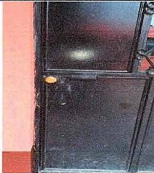
Foto 17: modulo 4 sustitucion de chapas
