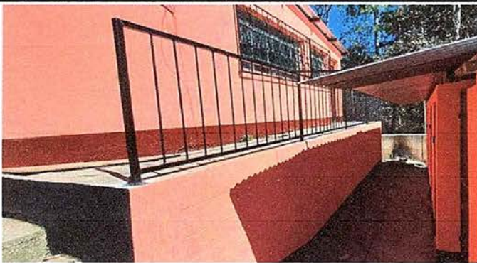
Foto 15: modulo 3 suministro e instalacion de baranda de metal
