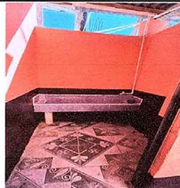
Foto 16: modulo 3 colocacion de azulejo al mingitorio
