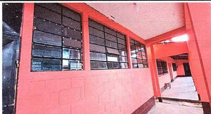
Foto 3: MODULO 1 Se sustituyeron los vidrios
