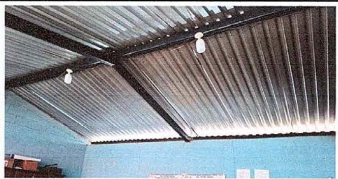
Foto 18: modulo 4 sustitucion de lamparas
