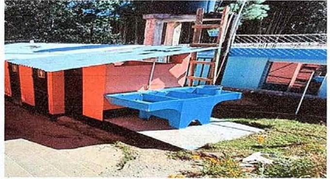
Foto 14:MODULO 3 Se realizó la instalacion de pila
