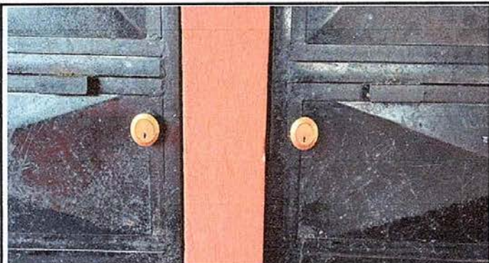
Foto 1: MODULO 1 se realizaron los trabajos de sustitucion de chapa
