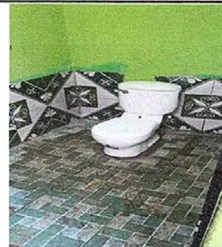
Foto 12: MODULO 3 sustitucion de sanitario
