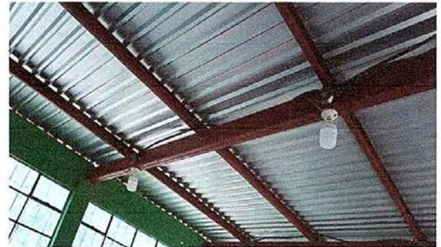
Foto 9: MODULO 2 sustitucion de plafoneras
