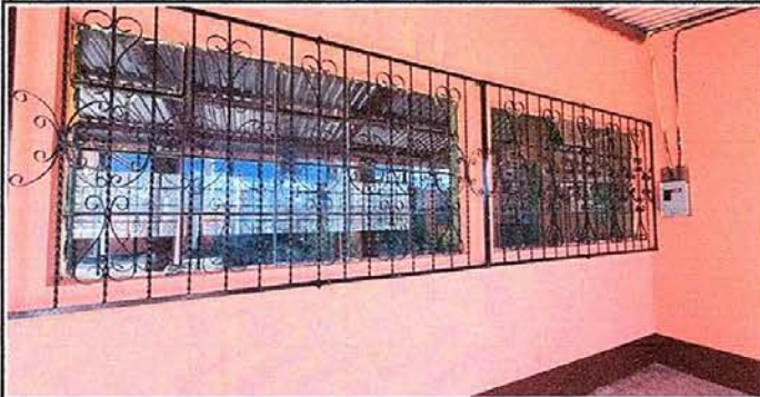
Foto 11: MODULO 3 sustitución de vidrios
