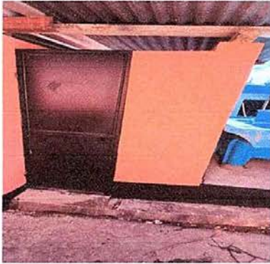
Foto 13: MODULO 3 suministro e instalacion de puerta de metal en mingitorio
