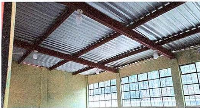
Foto 9: MODULO 2 sustitución de focos ahorradores
