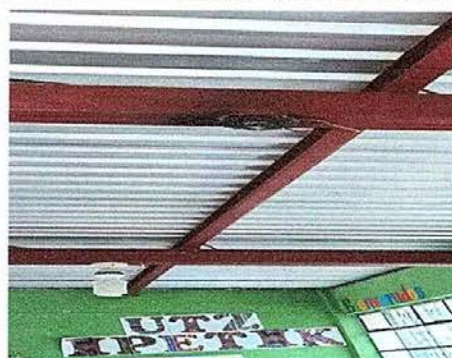
Foto 9: MODULO 2 sustitucion de plafoneras
