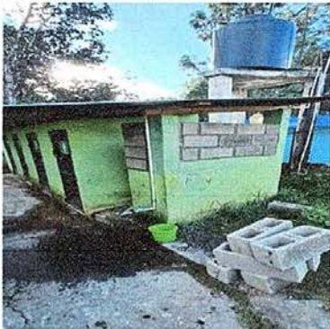
Foto 13: MODULO 3 trabajos en mingitorio
