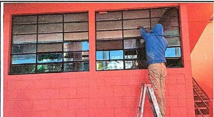
Foto 3: MODULO 1 trabajo de sustitucion de vidrios
