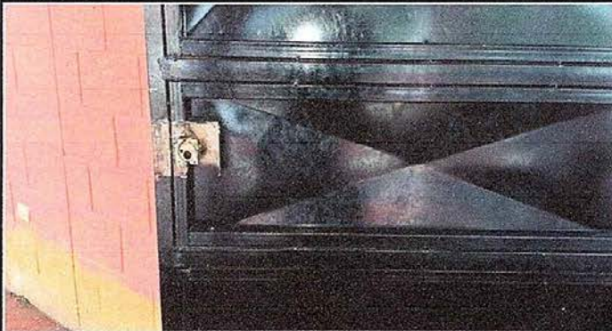
Foto1: MODULO 1 se muestra el trabajo de sustitucion de chapa
