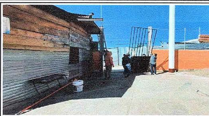
Foto 18: MURO PERIMETRAL Sustitucion de porton de entrada principal
