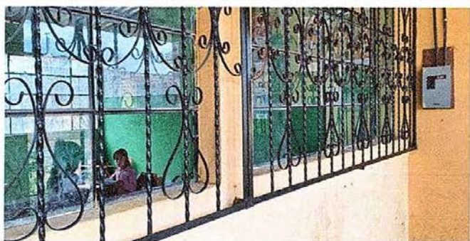
Foto 11: MODULO 3 sustitución de vidrios
