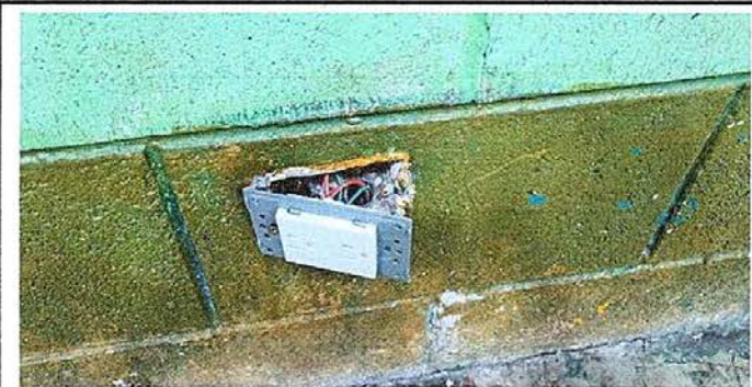
Foto 5: MODULO 1sustitucion de tomacorriente doble
