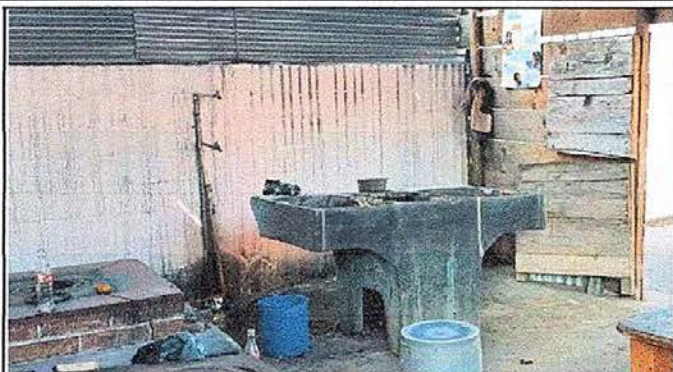
Foto 17: MODULO 4 sustitucion de pila
