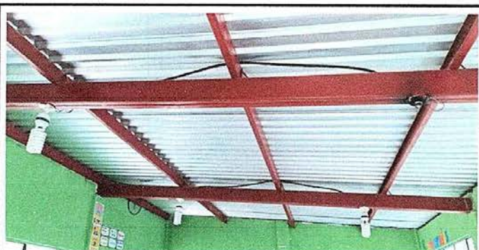
Foto 9: MODULO 2 sustitución de focos ahorradores
