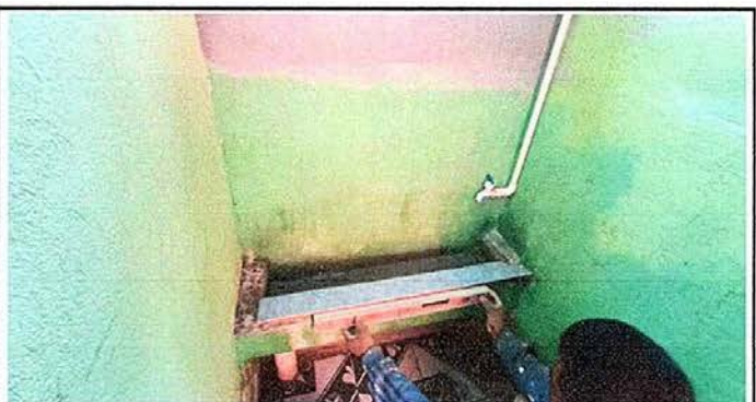
Foto 16: modulo 3 colocacion de azulejo al mingitorio
