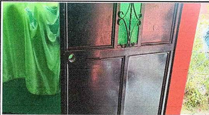
Foto 7: MODULO 2 Trabajo de sustitucion de chapa
