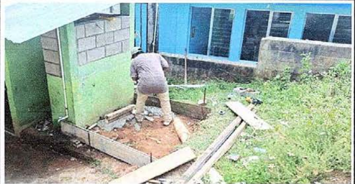
Foto 14:MODULO 3 trabajos para instalacion de pila
