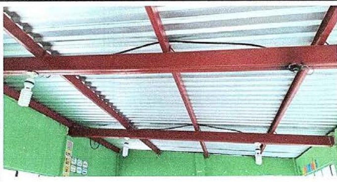
Foto 9: MODULO 2 sustitución de focos ahorradores
