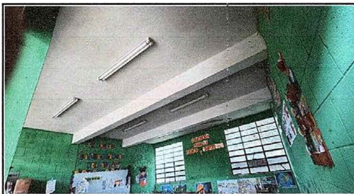
Foto 4: MODULO 1 fotografia donde se muestran las candelas que seran sustituidas por focos tipo led
