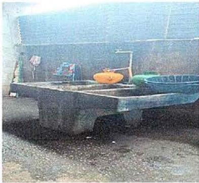
Foto 19: MODULO 4 sustitución de pila
