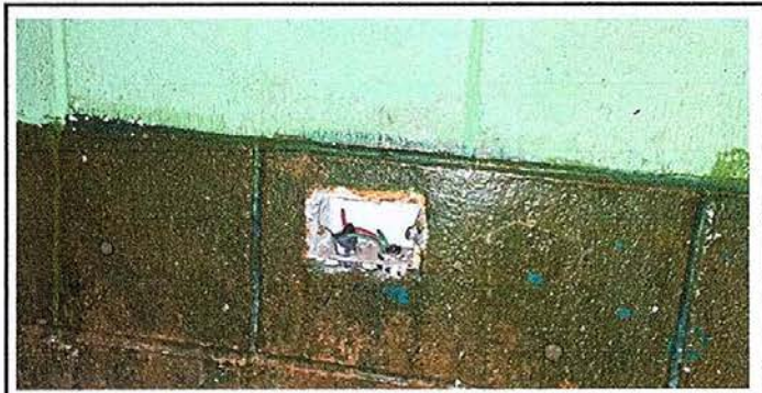
Foto 6: MODULO 1sustitucion de tomacorriente doble
