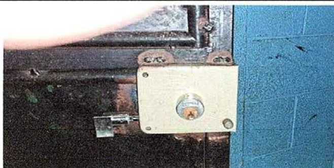
Foto 17: MODULO 4 sustitucion de chapa
