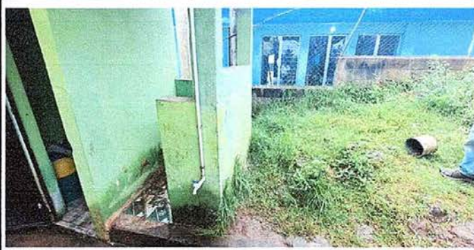
Foto 14: MODULO 3 instalacion de pila
