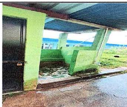
Foto 16: modulo 3 se colocara azulejo a la orilla del mingitorio
