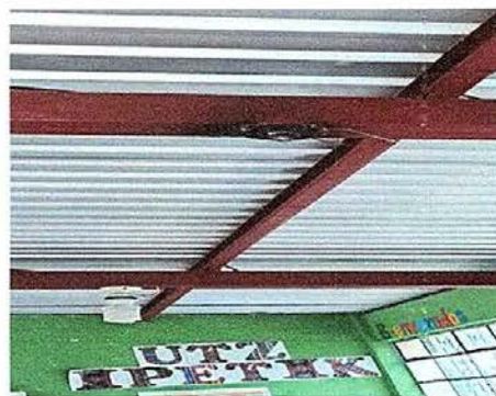
Foto 9: MODULO 2 sustitucion de plafoneras
