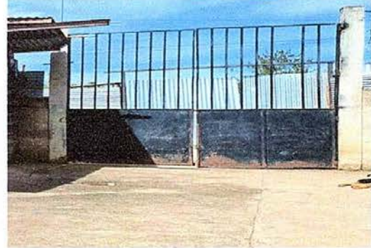
Foto 20: MURO PERIMETRAL se muestra el mal estado del portn de entrada el cual sera sustituido
