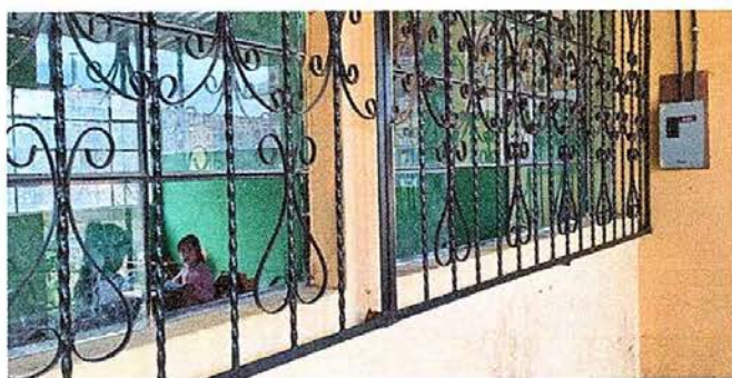
Foto 11: MODULO 3 sustitución de vidrios
