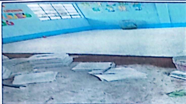
Foto 1: Sustitución de piso, piso granito, área de aula de Kinder.
