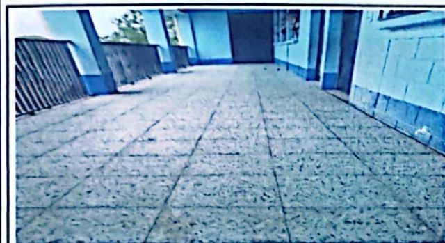
Foto 3: Sustitución de piso, piso granito, corredor segundo nivel.
