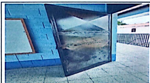
Foto 4: mantenimiento a estructura de puertas.
