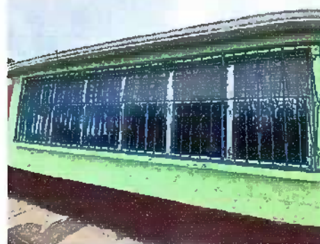
Modulo 3: Mantenimiento a balcones de metal
