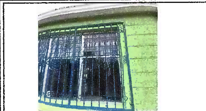
Modulo 3: Sustitucion de vidrios
