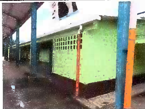
Modulo 3: Pintura en muros exteriores
