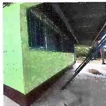
Modulo 2: Pintura en muros exteriores
