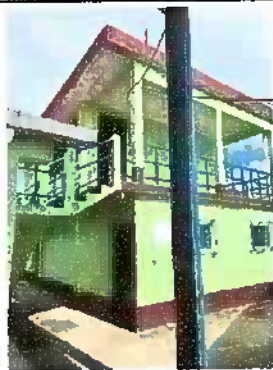
Modulo 4: Pintura en muros exteriores
