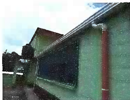
Modulo 3: Sustitución de canal de pvc
