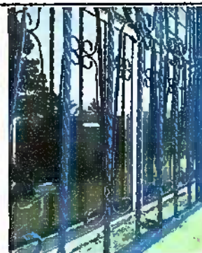
Modulo 3: Mantenimiento a balcones de metal
