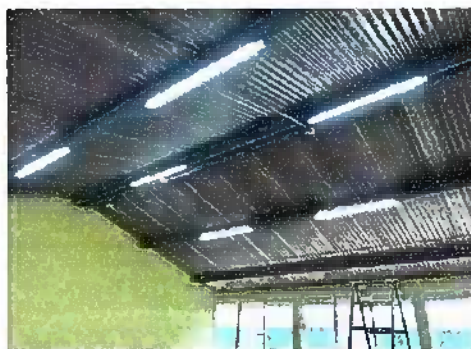
Modulo 1: Reparacion de cableado electrico
