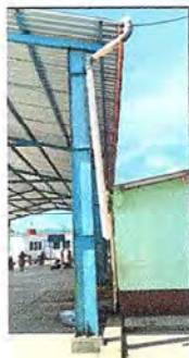
Foto 23 Modulo 3: Reparacion de bajada de agua tubo pvc 3"
