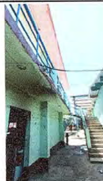
Foto 28 Modulo 4: Reparación de cableado eléctrico
