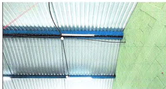
Foto 4 Modulo 1: Reparacion de cableado electrico
