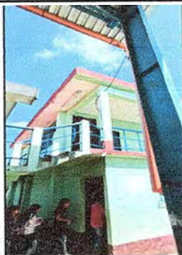
Foto 25 Modulo 4: Pintura en muros exteriores
