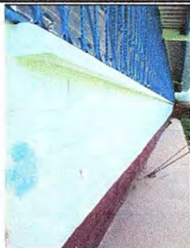
Foto 1 Modulo 1: Pintura en muros exteriores
