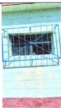
Foto 29 Modulo 4: Sustitución de vidrios
