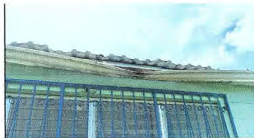
Foto 22 Modulo 3: Sustitución de canal de pvc
