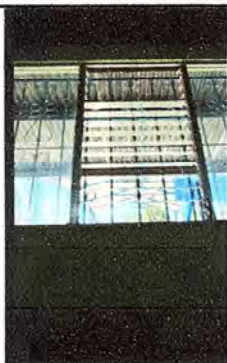
Foto 13 Modulo 2: Sustitucion de vidrios
