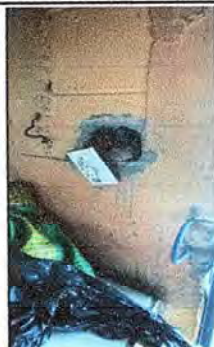
Foto 27 Modulo 4: Sustitución de interruptores dobles
