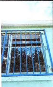
Foto 19 Modulo 3: Sustitucion de vidrios
