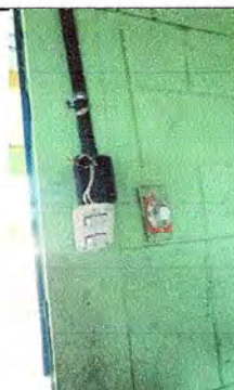
Foto 16 Modulo 3: Sustitución interruptores dobles
