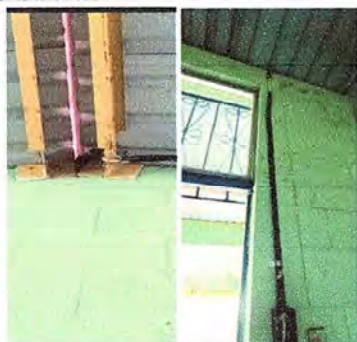
Foto 17 Modulo 3: Reparacion de cableado electrico
