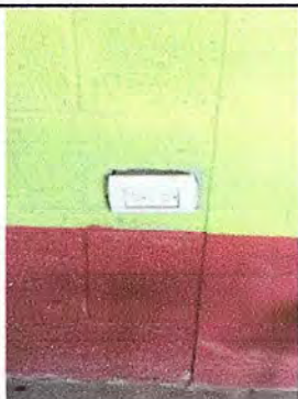
Foto 3 Modulo 1: Sustitucion de tomacorrientes doble
