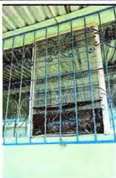
Foto 7 Modulo 1: Stitucion de vidrios
