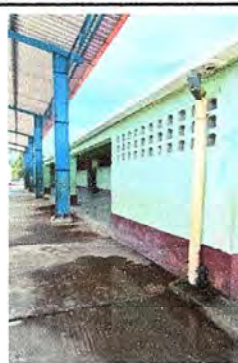
Foto 14 Modulo 3: Pintura en muros exteriores
