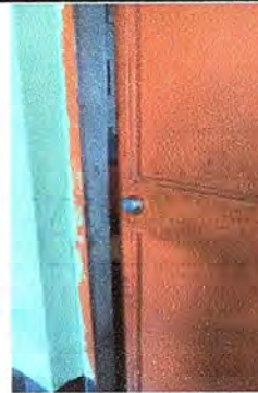
Foto 20 Modulo 3: Sustitucion de chapa
