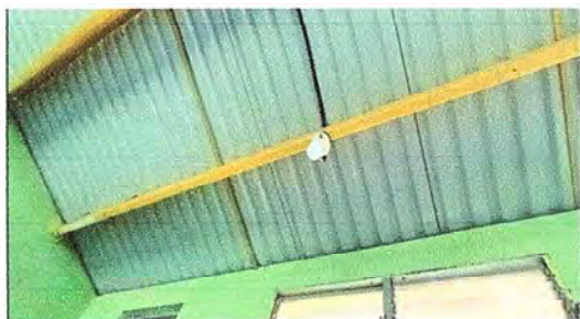
Foto 15 Modulo 3: Sustitucion de lamparas tipo led e Instalación de unidades luz (incluye interruptor y cable eléctrico)
