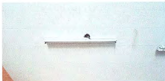
Foto 26 Modulo 4: Sustitución de lámparas tipo led e instalación de unidades luz (incluye interruptor y cable eléctrico)
