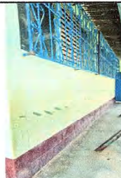
Foto 8 Modulo 2: Pintura en muros exteriores
