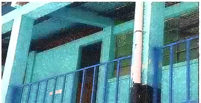
Foto 6: MODULO 4 MANTENIMIENTO A BARANDAS
