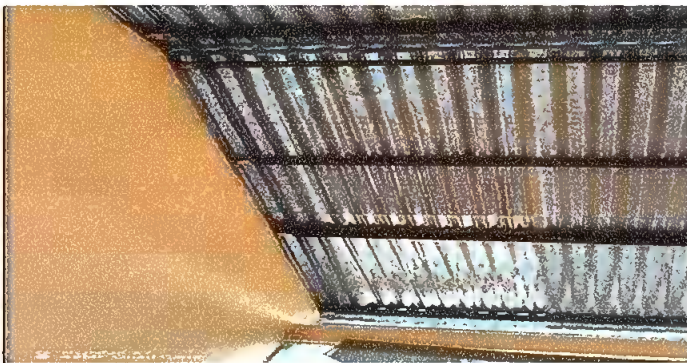
Foto 5: MODULO 4 SUSTITUCION DE LAMINA
