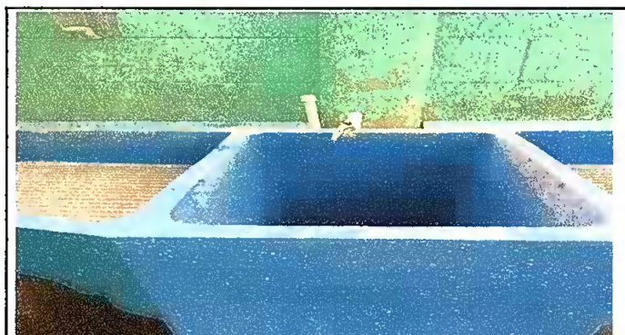
Foto 6: MODULO 1 Y 7 SUSTITUCION DE PILAS
