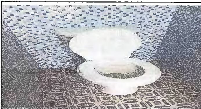
Foto 3: MODULO 7 SUSTITUCION DE INODORO
