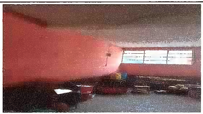
Foto 4: MODULO 1 PINTURA EN MUROS INTERIORES
