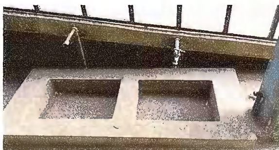
Foto 2: MODULO 3 SUSTITUCION DE LLAVE DE CHORRO
