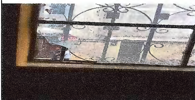
Foto 4: MODULO 3 SUSTITUCION DE VIDRIOS
