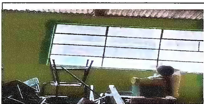
Foto 5: MODULO 2 PINTURA DE MUROS EXTERIORES E INTERIORES
