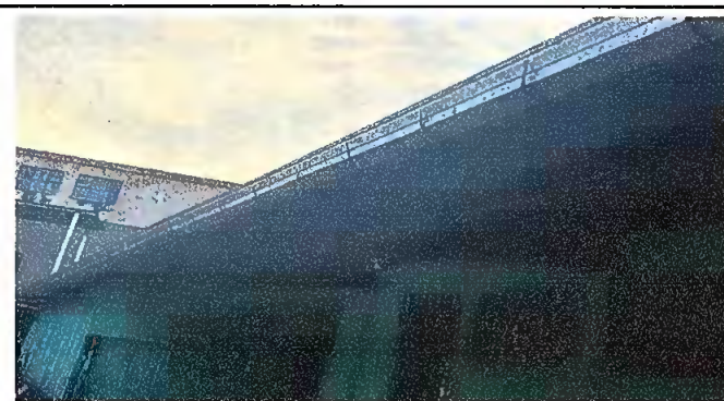
Foto 5: MODULO 5 SUSTITUCION DE SOPORTE O PESCANTE DE METAL PARA CANAL
