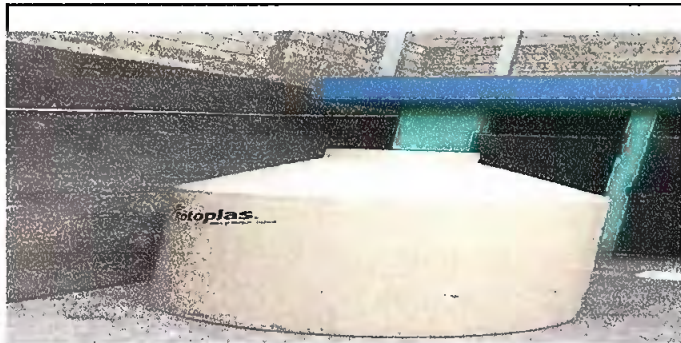
Foto 3: MODULO 7 SUSTITUCION DE TAPADERA
