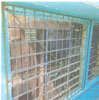
Foto 3: Durante el remozamiento se colocaron los balcones solicitados, en esta foto se ve la recineta soldadura de la misma.
