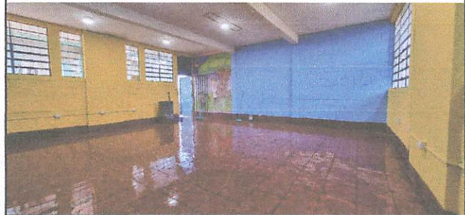
Foto 2: Antes de la entrega de las aulas donde se colocó el piso cerámico se hizo un lavado después de la colocada del piso.
