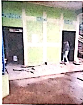
Foto 1: Cambio de Puertas en las aulas del primer nivel
