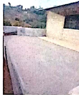
Foto 2: Pavimento frente de la cocina
