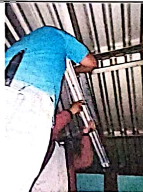
Foto 4: Colocación de focos
