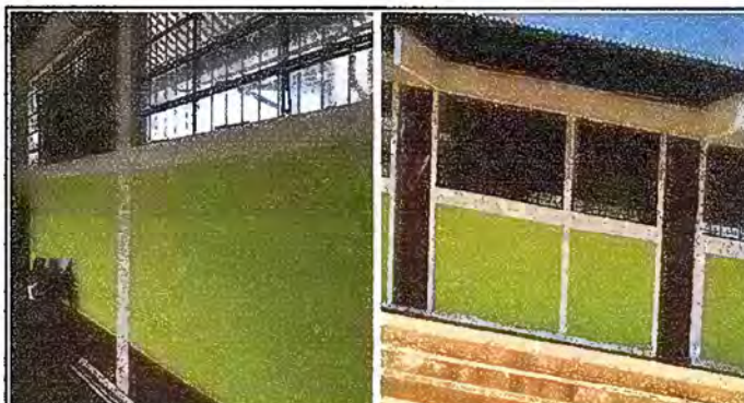
Módulo 2: Pintura en paredes interiores y exteriores
