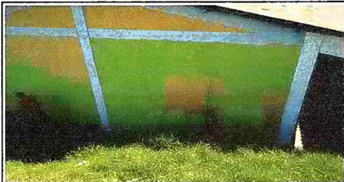
Módulo 3: Pintura en paredes interiores y exteriores
