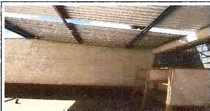
Módulo 2: Sustitución de lámina por lámina troquelada
