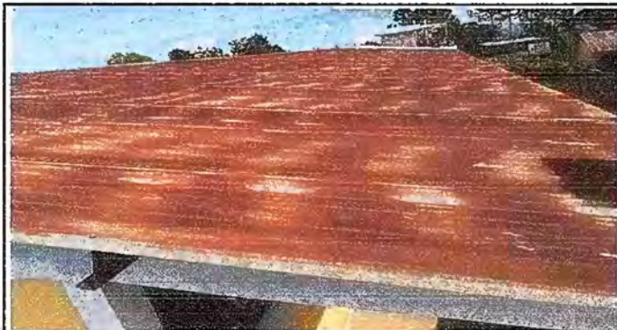
Módulo 1: Sustitución de lámina por lámina troquelada
