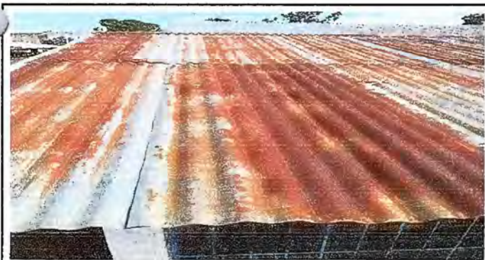
Módulo 2: Sustitución de lámina por lámina troquelada
