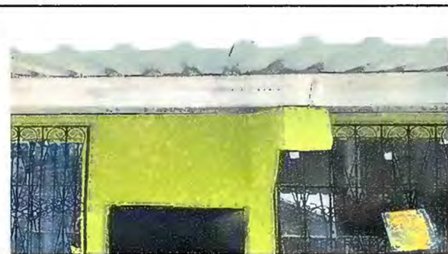
Foto 5: Sustitución de lámina, por lámina troquelada aluzinc calibre 26
