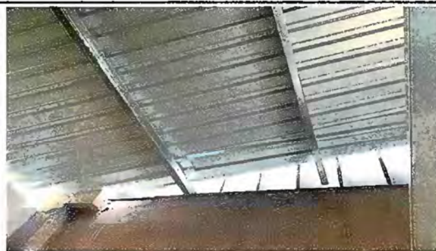
Foto 4: .Sustitución de estructura de soporte de madera, por metal.
