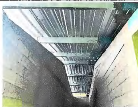
Foto 2: Sustitución de lámina, por lámina troquelada aluzinc calibre 26.
