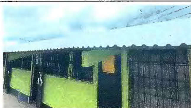
Foto 3: Sustitución de lámina, por lámina troquelada aluzinc calibre 26.
