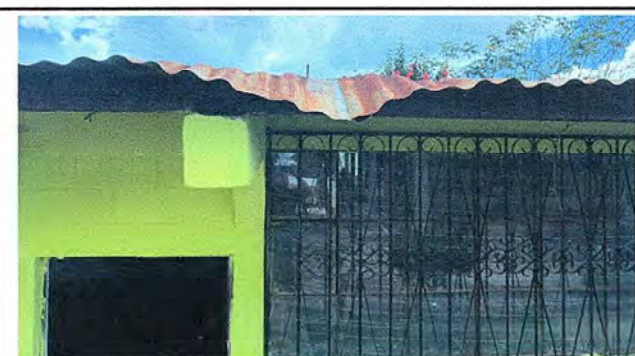
Foto 5: Módulo 2, sustitución de lámina, por lámina troquelada aluzinc calibre 26.
