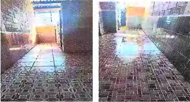
Foto1: Módulo 1 Sustitución de piso de torta de concreto por piso antideslizante en baños de niñas y niños.
