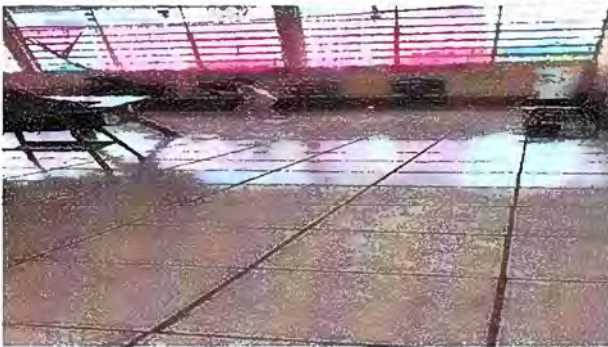
Foto 3: Módulo 2 Sustitución de piso de torta de concreto por piso cerámico en aula de primero y segundo primaria.
