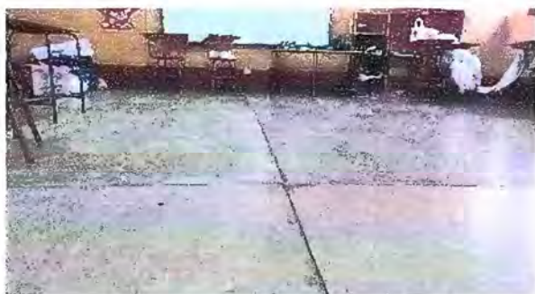
Foto 3: Módulo 2 Sustitución de piso de torta de concreto por piso cerámico en aula de primero y segundo primaria.
