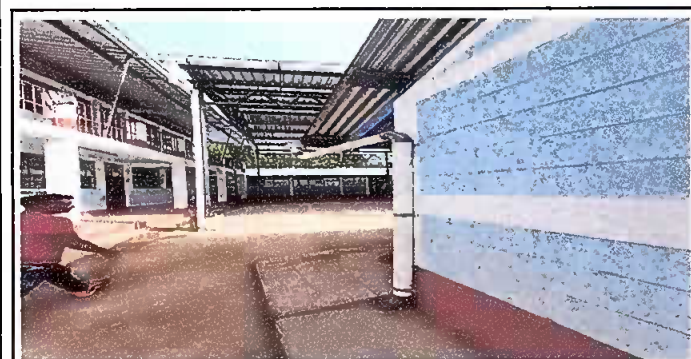
Foto 5: Modulo 2 Sustitucion de tubo Pvc Para calda Pluvial
