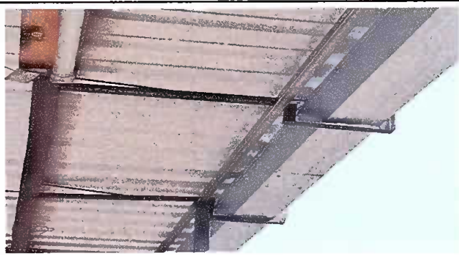
Foto 2: Modulo 1 Suministro de pescantes
