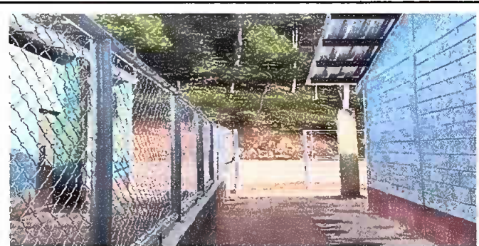
Foto 12: Muro Perimetral, Reparacion de malla y tubo HG y puerta secundaria.
