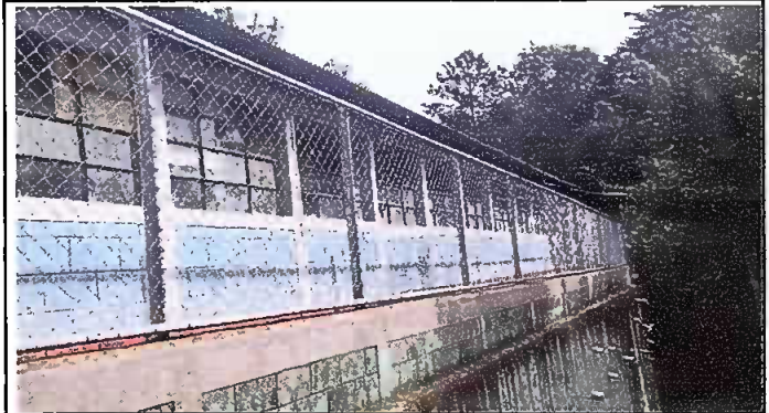
Foto 10: Muro Perimetral Reparacion de malla y tubo hg
