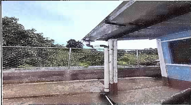
Foto 7: Modulo 3 Sustitucion de tubo Pvc calda pluvial
