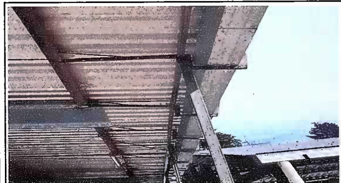
Foto 3: Modulo 1 Sustitucion de canal de metal
