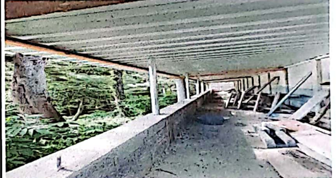
Foto 4: Reparación de muro perimetral con block y tubo HG
