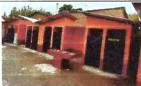
Foto 11: Servicio sanitario: Sustitución de lamina por lamina troquelada aluzinc calibre 26
