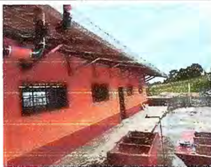
Foto 5: Modulo 1: Sustitución de canal de metal
