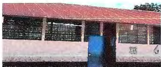
Foto 7: Módulo 2: Sustrucción de canal de metal
