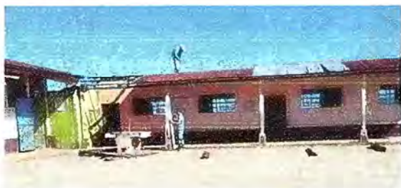
Foto 5: Modulo 1: Sustitución de canal de metal
