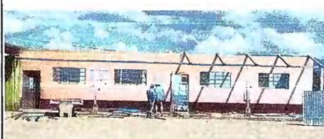
Foto 2: Modulo 1: Sustitución de estructura de soporte de madera, por metal
