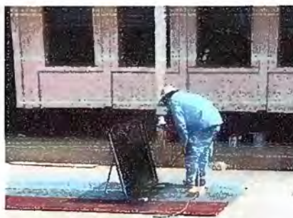
Foto 8: Módulo 4: Mantenimiento a estructura de puerta (aplicación de pinturas)
