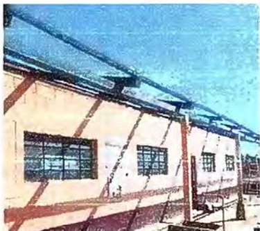
Foto1: Modulo1: Sustitución de lámina, por lamina troquelada aluzinc calibre 26
