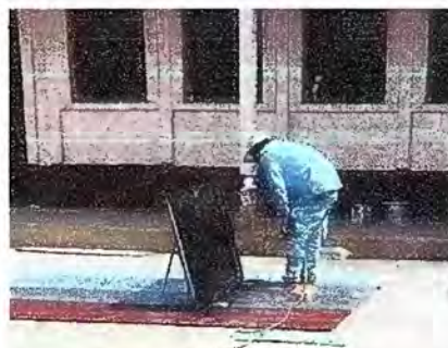
Foto 6: Modulo 2: Mantenimiento a estructura de puerta (aplicación de pinturas)
