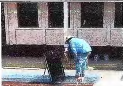
Foto 3: Modulo 1: Mantenimiento a estructura de puerta (aplicación de pinturas)
