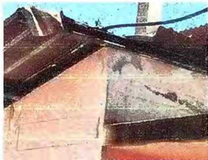
Foto 11: Servicio sanitario: Sustitución de lamina por lamina troquelada aluzinc calibre 26
