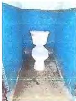
Foto 13: Servicio Sanitario: Colocación de azulejo
