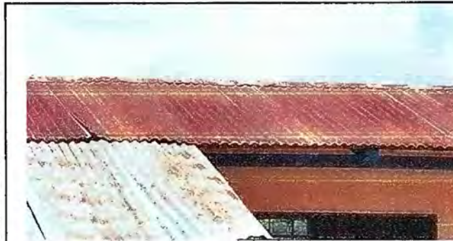
Foto 5: Modulo 1: Sustrución de canal de metal
