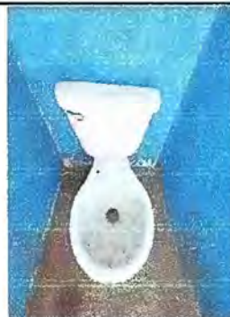
Foto 10: Servicio Sanitario: Sustitucion de inodoro
