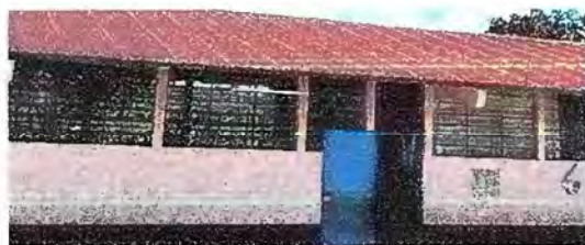
Foto 7: Modulo 2: Sustitución de canal de metal
