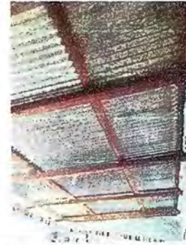
Foto 2: Modulo 1: Sustrución de estructura de soporte de madera, por metal
