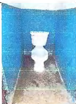
Foto 12: Servicio Sanitario: Sustitución de piso de torta por piso de granito
