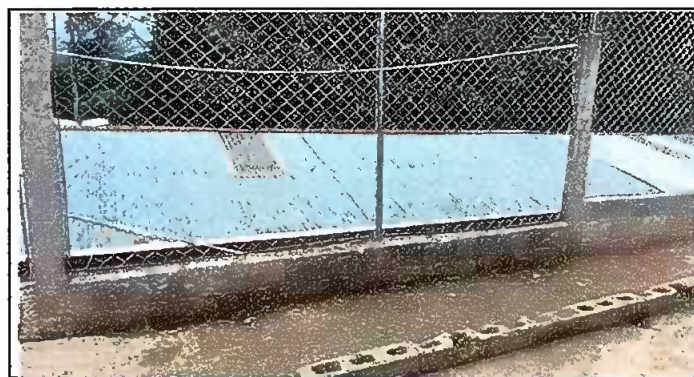
Foto 6: Reparación de tubo hg y malla galvanizada
