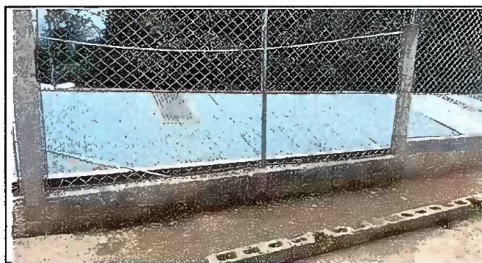
Foto 6: Reparación de tubo hg y malla galvanizada
