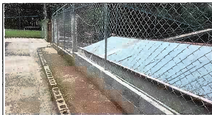
Foto 5: Reparación de tubo hg y malla galvanizada
