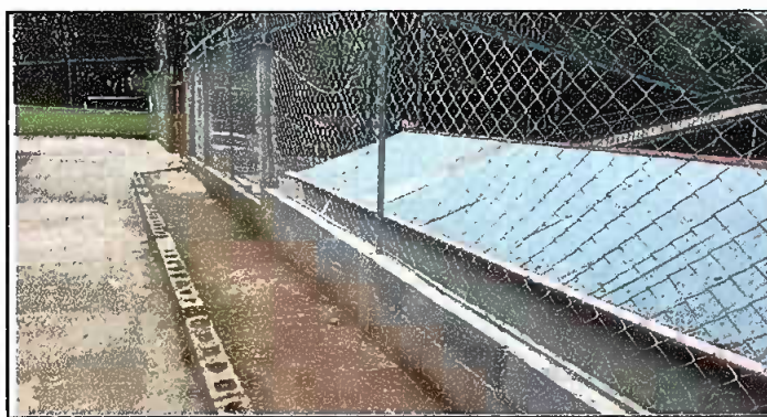
Foto 5: Reparación de tubo hg y malla galvanizada
