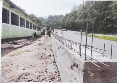
Foto1: Reparación de muro de perimetral de blok
