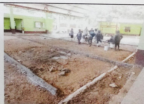
Foto 6: Reparación de plancha de concreto de patio
