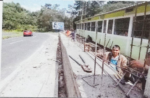
Foto 3: Reparación de muro de perimetral de blok
