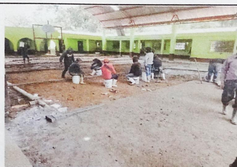
Foto 4: Reparación de plancha de concreto de patio
