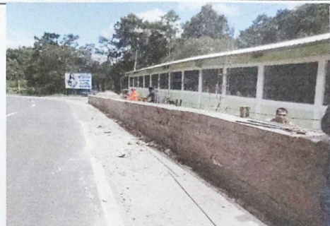
Foto 2: Reparación de muro de perimetral de blok
