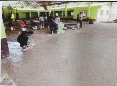
Foto 5: Reparación de plancha de concreto de patio
