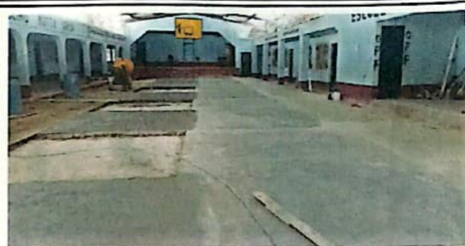
Foto 2: Enfrente de la dirección, repación de plancha de concreto de patio.
