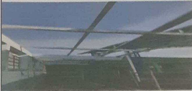
Foto 1: Sustitución de soporte de hierro por soporte de metal
