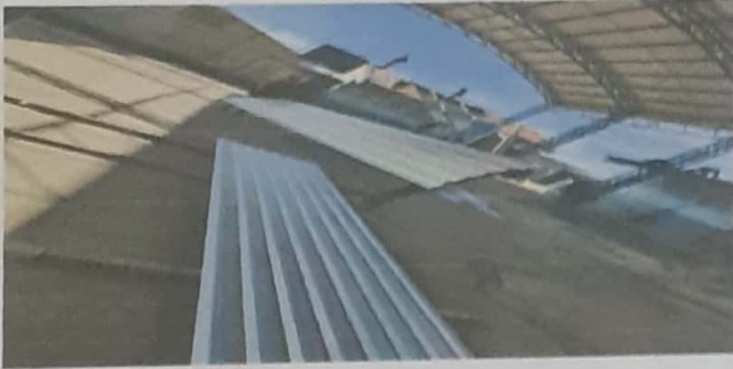
Foto 3: sustitución de láminas
