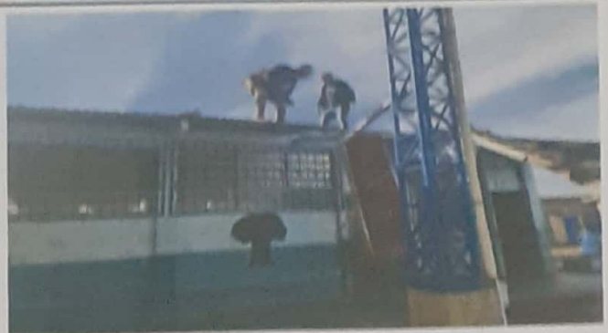
Foto 2: Sustitución de laminas duralita por laminas troquelada
