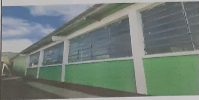
Foto 5: Pintura de paredes exteriores e interiores
