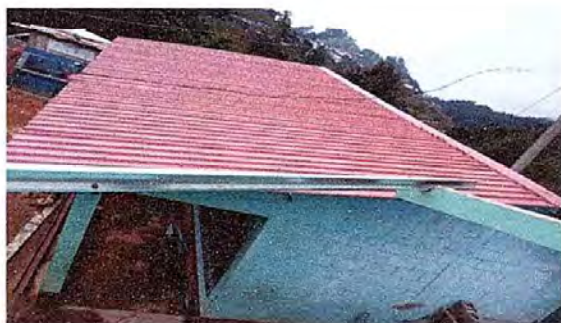
modulo 1 foto 5 sustitucion de laminas por laminas troqueladas
