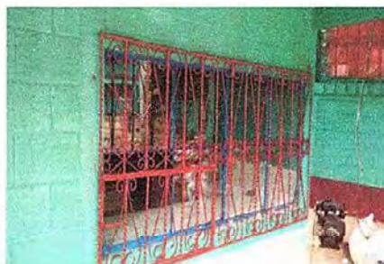
foto 2 mudulo 1 sustitucion de vidrios
