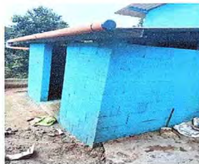
foto 14 modulo 2 reparacion de muro de block
