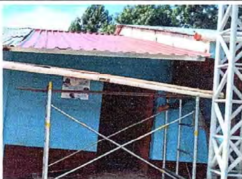
foto 19 modulo 5 sustitucion de laminas por laminas troquelada
