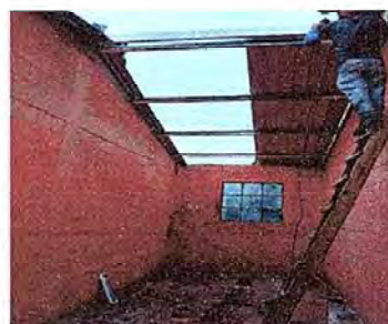
foto 20 modulo 5 sustitucion de costanera por metal
