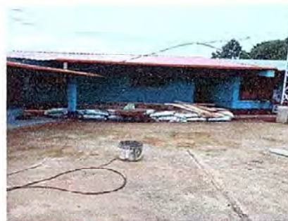
foto 16 modulo 3 sustitucion de laminas por laminas troquelada
