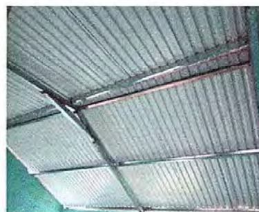
modula 1 foto 4 sustitucion de costanera de madera por metal
