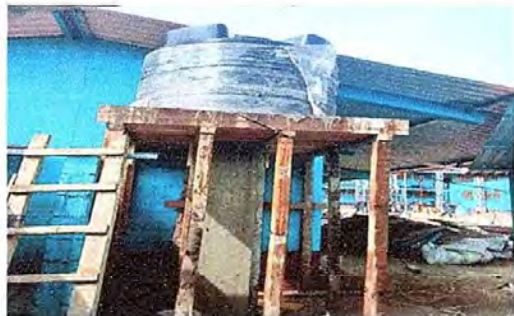
foto 7 modulo 2 sustitucion de deposito de agua 1700lts
