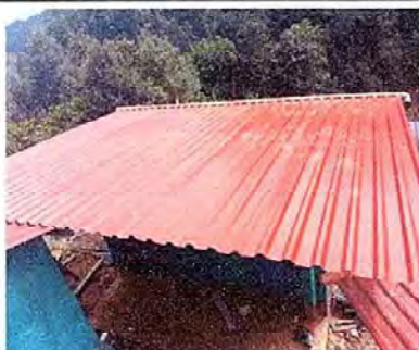
foto 17 modulo 4 sustitucion de laminas por laminas troquelada
