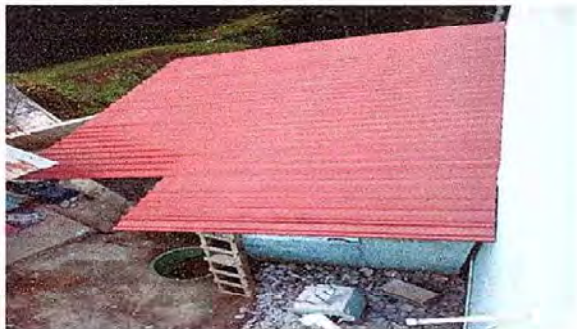
foto 11 modulo 2 sustitucion de laminas por laminas troqueladas
