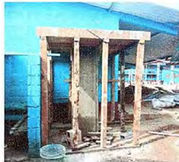
foto 8 modulo 2 sustitucion de base de concreto
