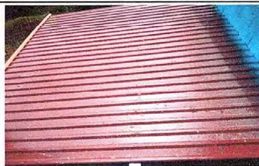
Foto 14: Modulo 4 sustitucion de laminas por laminas troquelada
