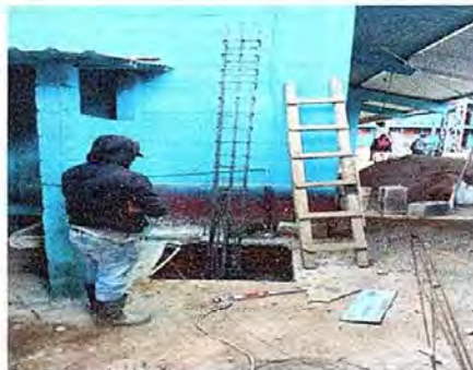
Foto 8 Modulo 2 sustitucion de base de concreto
