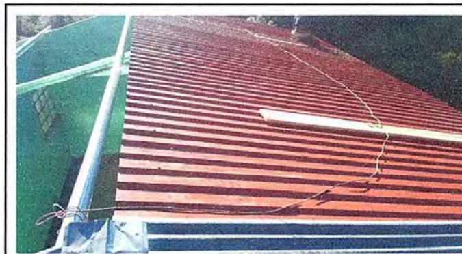
Foto 4: Modulo 1 sustitucion de soporte de madera por metal.
