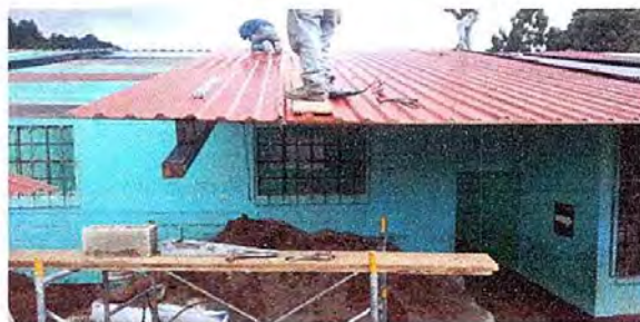
Foto 4: Modulo 3 sustitucion de laminas por laminas troquelada
