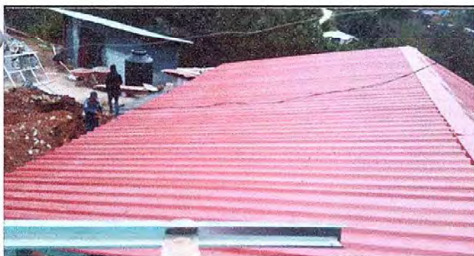
Foto 5: Modulo 1 sustitucion de laminas por laminas troquelada
