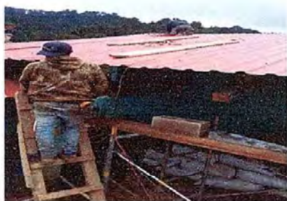
Foto 11: Modulo 2 sustitucion de laminas por laminas troquelada
