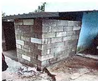
Foto 2: Modulo 2 Reparacion de muro de block
