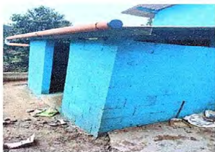
Foto 9: modulo 2 suministro instalacion de puerta
