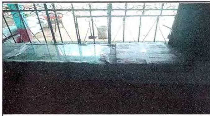
Foto 2: Modulo 1 Sustitucion de vidrios
