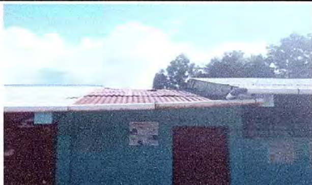
Foto 18 Modulo 5 sustitucion de lamina por lamina troquelada
