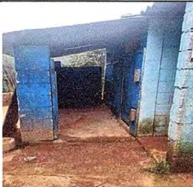
foto 8 Módulo 2 suministro instalacion de puerta
