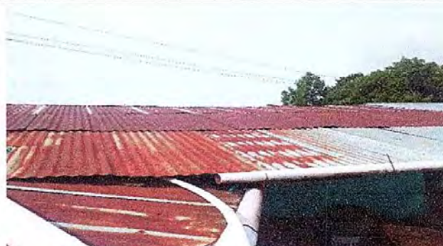
foto 15 Modulo 3 sustitucion de lamina por lamina troquelada
