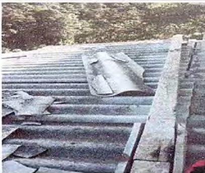
foto 10 Módulo 2 sustitucion de lamina por lamina troquelada.
