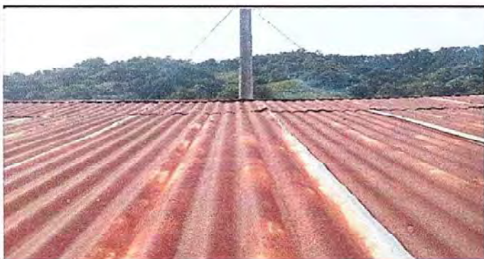
Foto 4 Módulo 1 Sustrucción de láminas por láminas troquelada.
