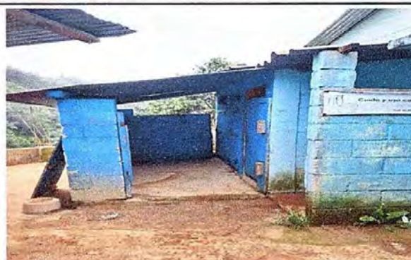
Foto 13 Modulo 2 Reparacion de muro de block.
