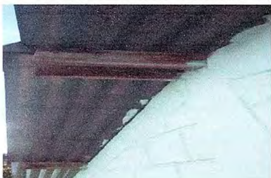
foto 14 Modulo 3 sustitucion de soporte madera por metal
