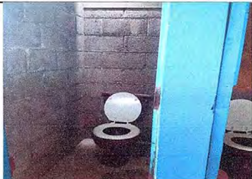
Foto 12 Modulo 2 sustitucion de accesorios de inodoro
