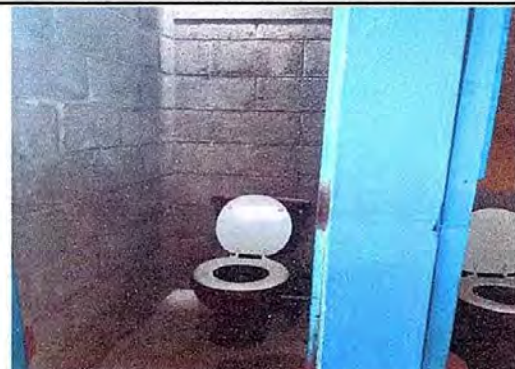
foto 9 Módulo 2 suministro instalacion de puerta de baños
