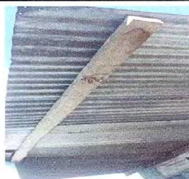
Foto 19 Modulo 5 sustitucion de madera por metal
