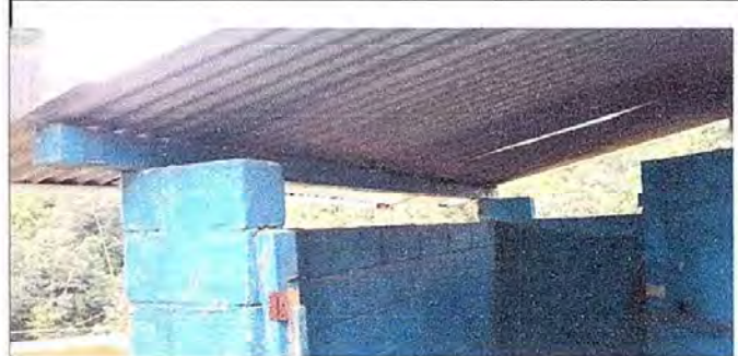
foto 11 Módulo 2 sustitucion de estructura de soporte de madera por metal
