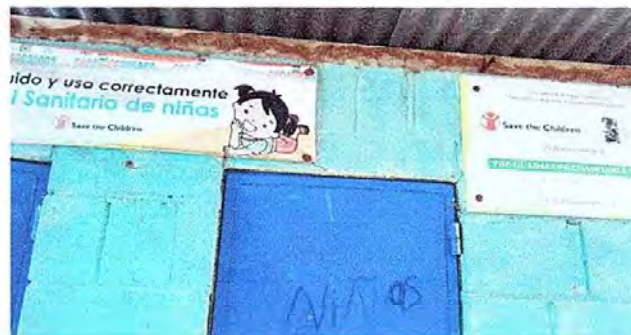
foto 17 Modulo 4 sustitucion de madera por metal
