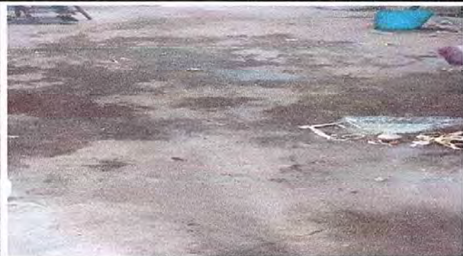
Foto 1 Módulo 1 Sustrucción de piso de concreto por piso cerámica.
