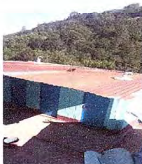
foto 16 Modulo 4 sustitucion de lamina por lamina troquelada
