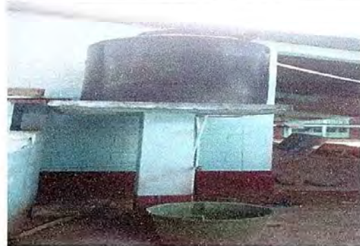
foto 7 Módulo 2 Sustitucion de base de concreto
