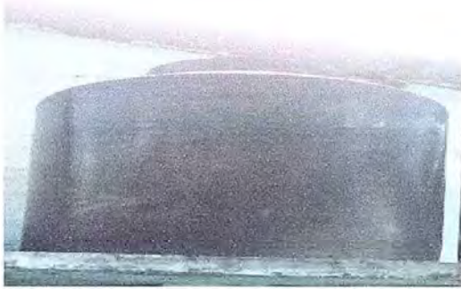
Foto 6 Módulo 2 sustitucion de deposito de agua 1700 lt.
