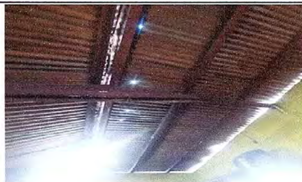
Foto 4 Módulo 1 Sustrucción de soporte de madera por metal.
