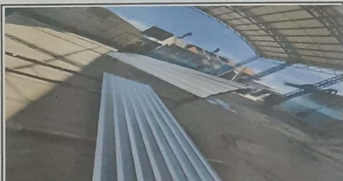
Foto 5: Sustitucion de láminas
