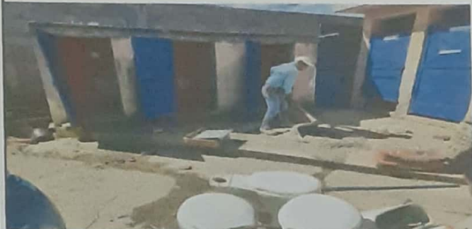
Foto1: Mantenimientos de puertas de baños
