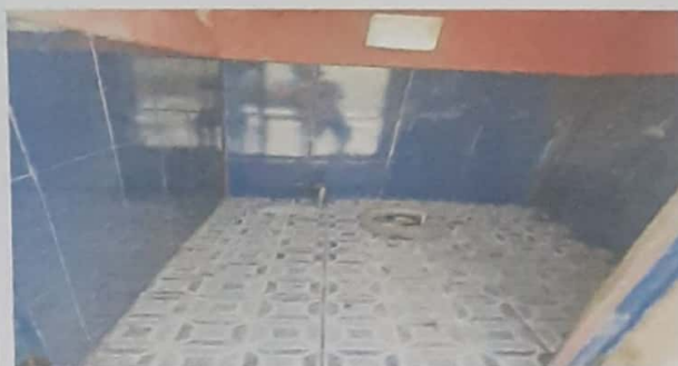
Foto 6: Sustitución DE Inodoros
