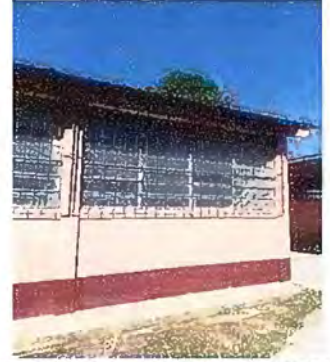
Foto 2: Módulo 2, sustitución de vidrios y balcones de metal.
