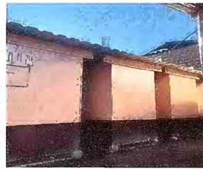
Foto 4: Módulo 4, sustitución de lámina por lámina troquelada aluzinc cal. 26.
