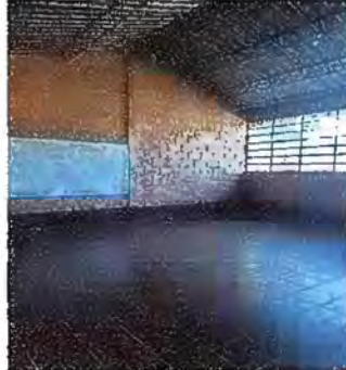
Foto 3: Módulo 3, sustitución de vidrios, balcones de metal y sustitución de piso de concreto por piso cerámico.
