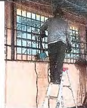
Foto 2: Modulo 2, sustitución de vidrios y balcones de metal.
