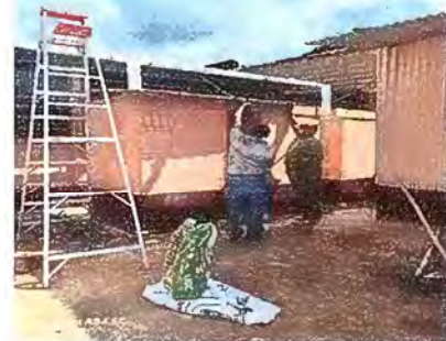
Foto 4: Módulo 4, sustitución de lámina por lámina troquelada aluzinc cal. 26.
