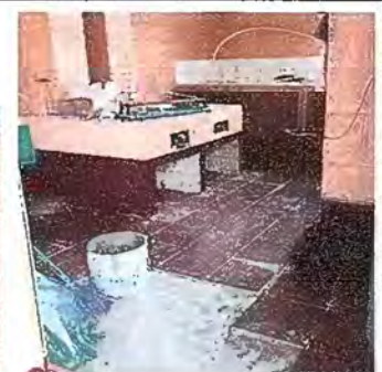
Foto 6: Módulo 6, suministro e instalación de balcones de metal, sustitución de piso de concreto por piso cerámico, sustitución de pila de concreto de un ala por pila de dos alas y sustitución de plancha de metal.
