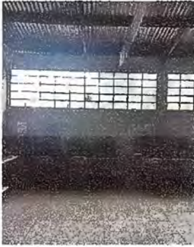
Foto1: Módulo 1: sustitución de vidrios
