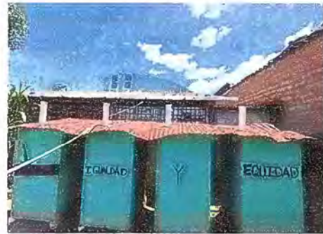
Foto 4: Módulo 4, sustitución de lámina por lámina troquelada aluzinc cal. 26.
