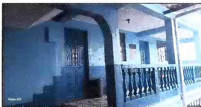
Foto 5: Módulo 2 (Planta alta y baja) - Mantenimiento a estructura de puerta (lijado, cambio de tubo, cepillado, sujeciones, aplicación de pintura).
